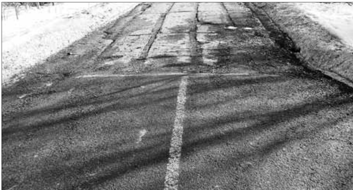
■ Улица Маслова была заасфальтирована до конечной остановки автобуса № 44; после нее пока осталось старое покрытие из плит. ФОТО: АЛЕКСЕЙ МОРОЗОВ
